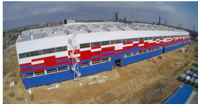
Завод «Русские электрические двигатели», строительные металлоконструкции
