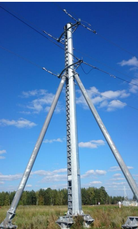
Магистральный нефтепровод «Куюмба-Тайшет», опоры ЛЭП 6-10 кВ
