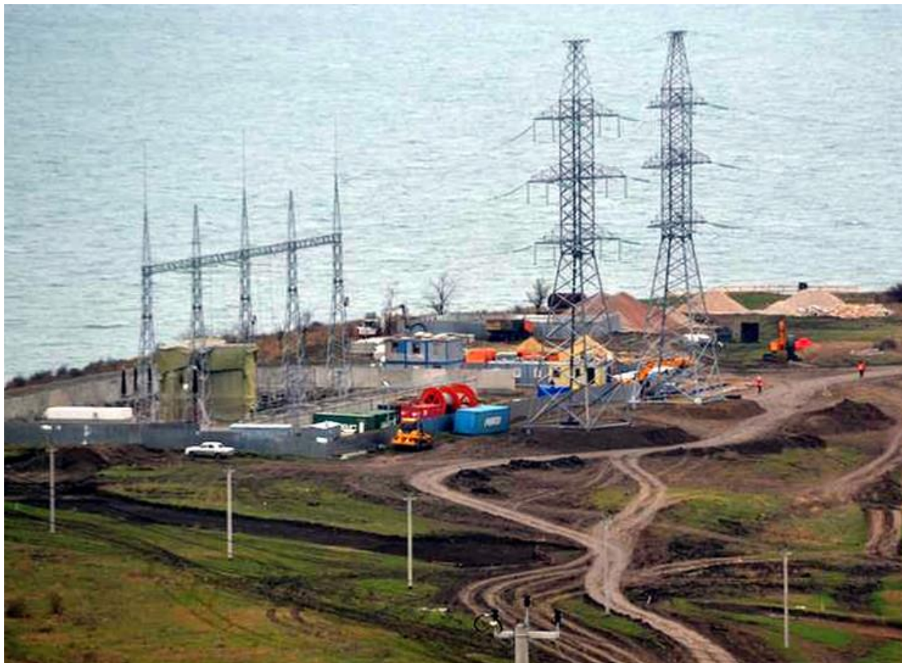
Энергомост в Крым – поставка опор ЛЭП 500 кВ
