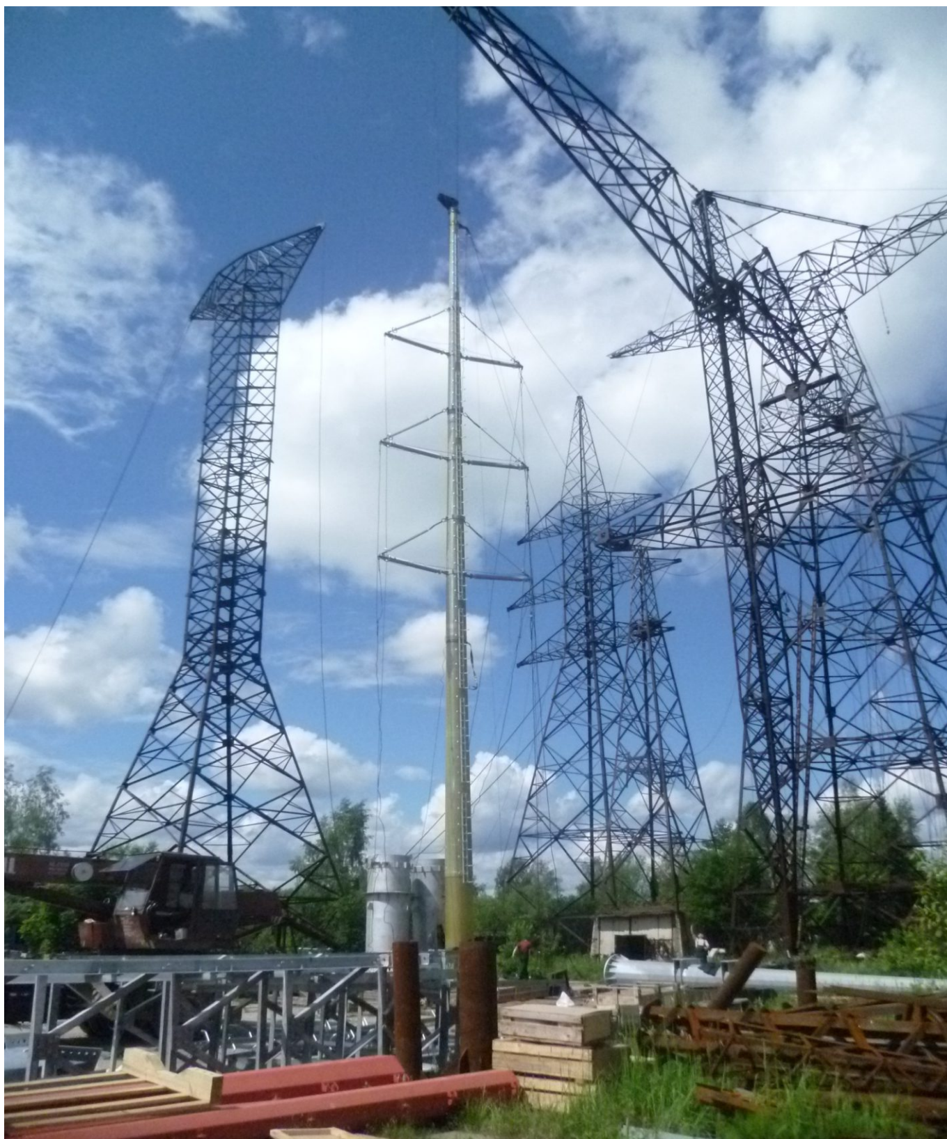
Установка опоры ПК 220-2 (испытания)
